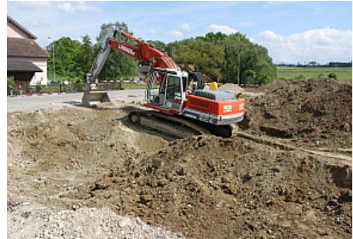
Bereits sind die Bagger beim Aushub für das Projekt.
