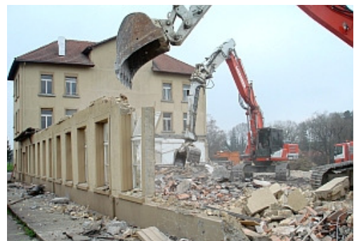
2010 machten die Bagger das alte Gebäude dem Erdboden gleich.
